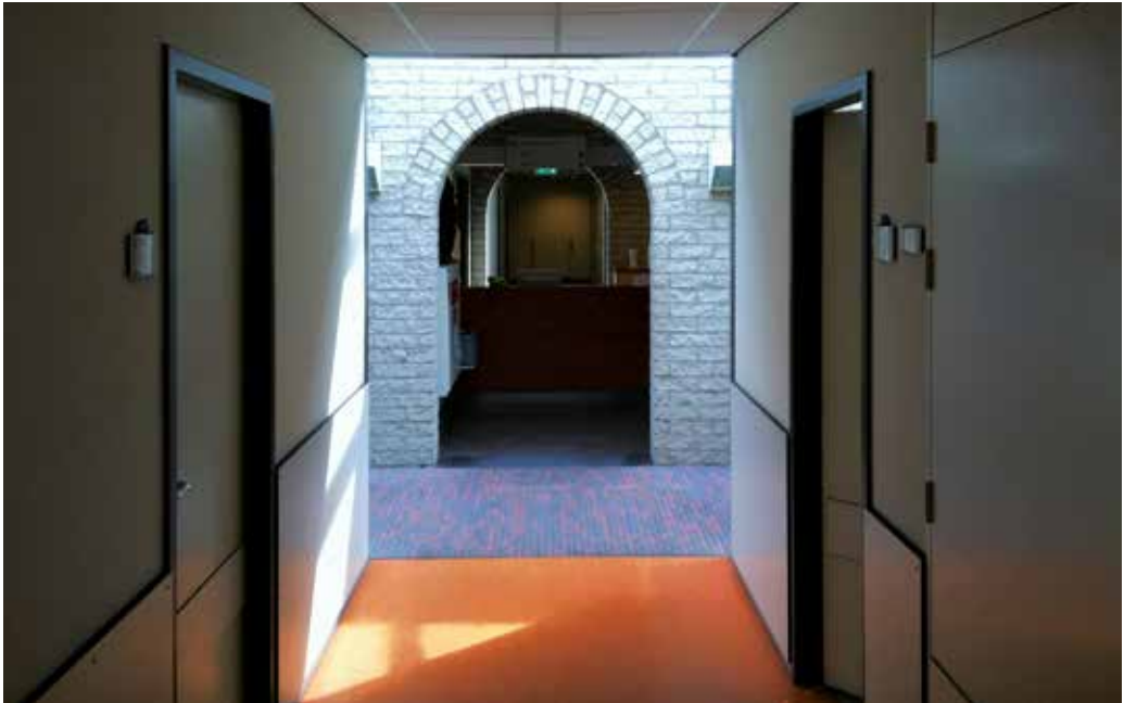
Abb. 13 Vor dem Umbau.
